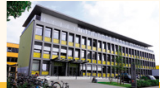
Die neue Leibnizschule: Der Blick auf unseren Haupteingang in der Röntgenstraße.
